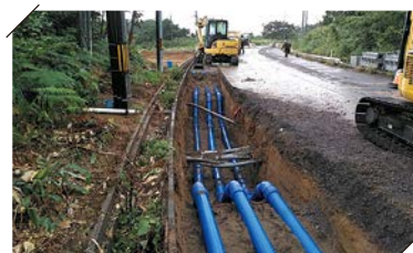
送水管布設工事
