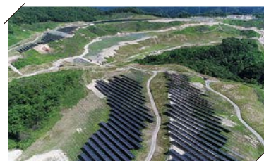
太陽光発電所造成工事
