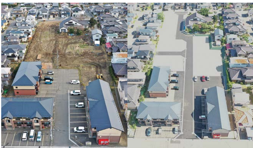
造成工事(工事前、工事後)
