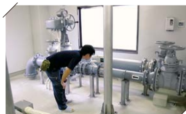
設備巡回点検中
