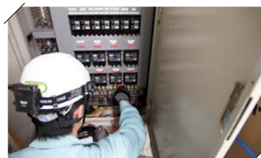
分電盤点検作業
