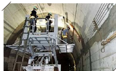
トンネル工事の様子
