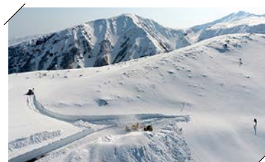
県単道路除排雪作業業務委託
