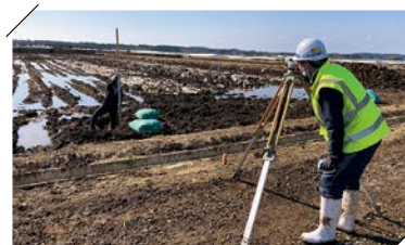
作業現場風景
