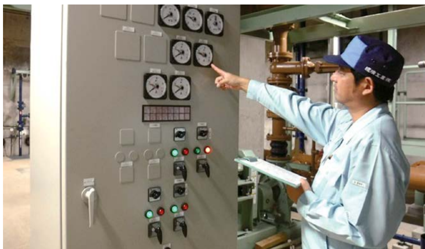
施設維持管理状況
