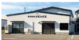
本社(にかほ市)技術棟1 社屋
