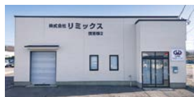
本社(にかほ市)技術棟2 社屋
