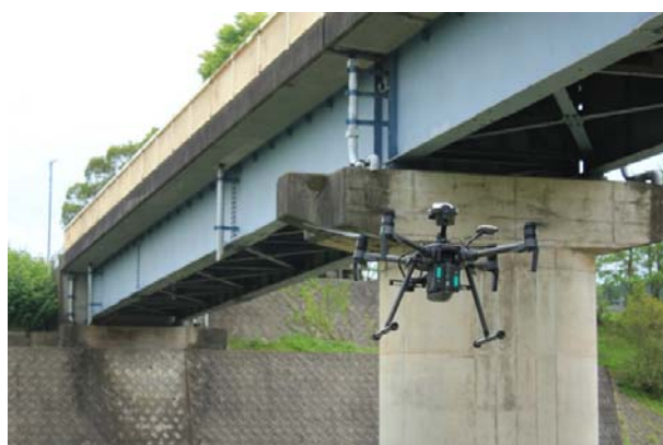
ドローンによる点検状況
