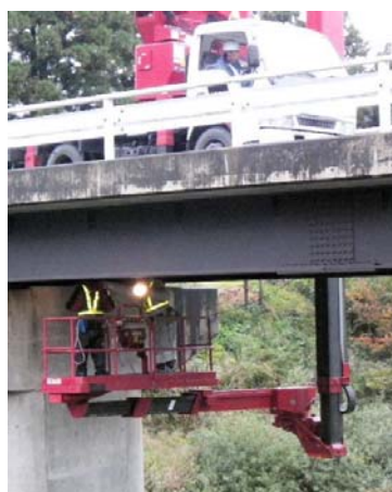
写真3.3 点検車による点検
