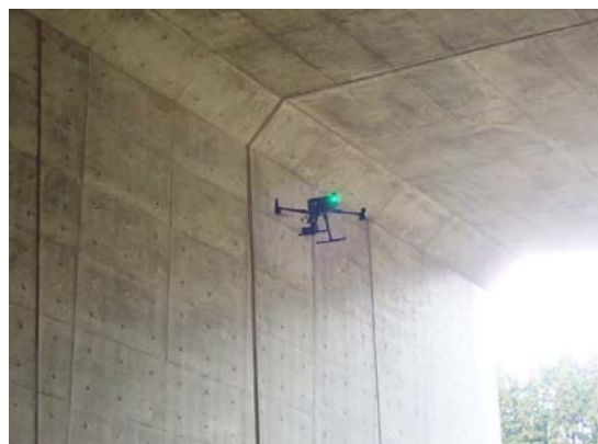
ドローンによる点検状況
