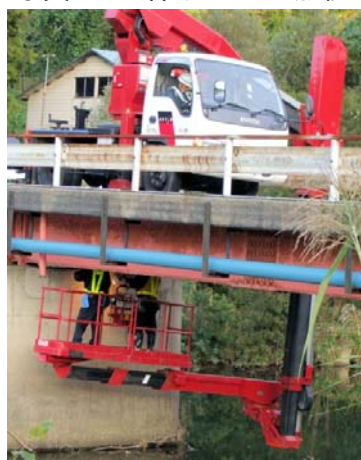
写真3.3 点検車による点検
