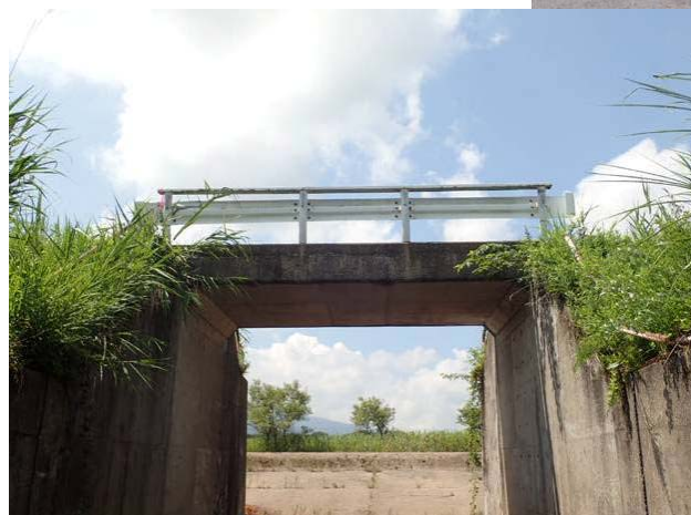
ボックスカルバート (3011号橋)
