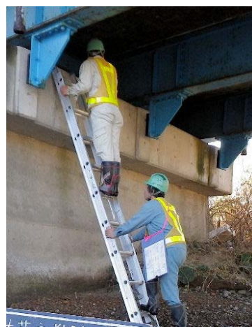
写真3.2 梯子による点検
