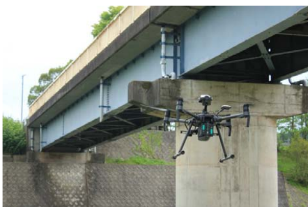
ドローンによる点検状況
