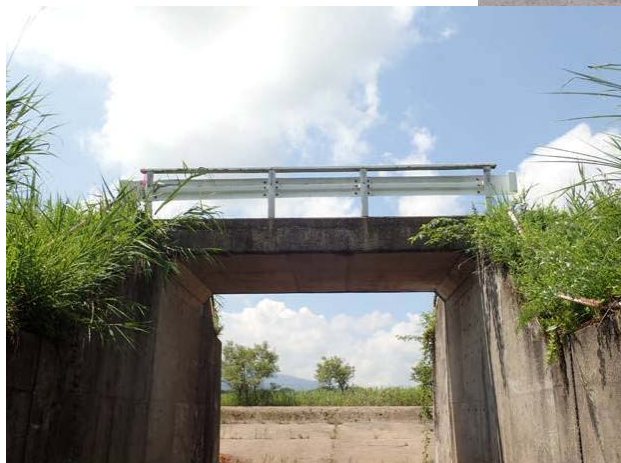
ボックスカルバート (3011号橋)
