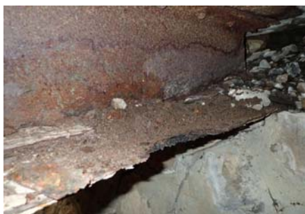
鋼桁の腐食
