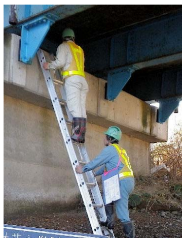
写真3.2 梯子による点検
