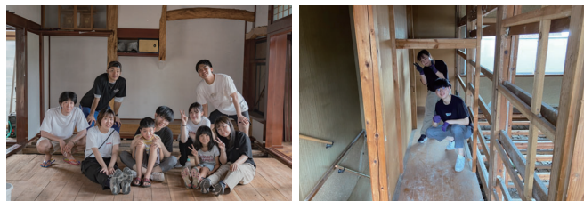
この夏はインターンコミュニティ「メディアラボ」プログラムで来た県内外の学生や地域の人たちと共に改修作業を行いました。
