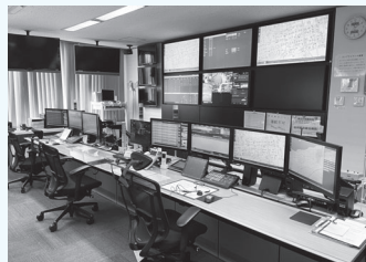
《消防費》高機能消防指令センターのシステムを更新し、消防活動環境を整備
