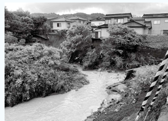
《災害復旧費》7月に発生した豪雨災害に対し、公共土木施設の応急復旧等を実施
