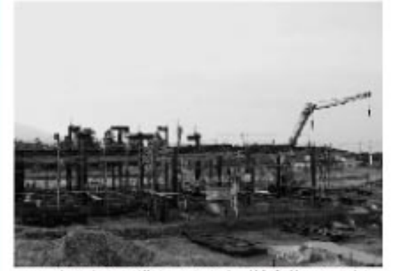
▲工事は順調に進んでいます（給食共同調理場の上棟）
