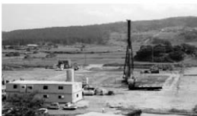
体育館等の建設は順調に進んでいます
