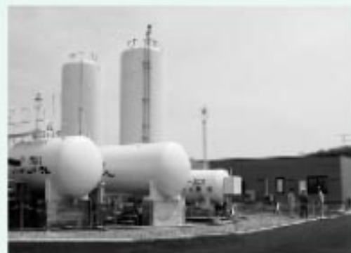
熱量変更に向けて、黒川地域に建設された新都市ガス製造所
