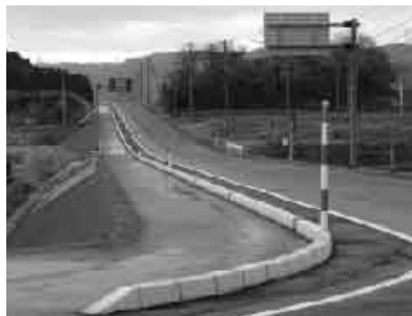
幅3mの歩道の設置で、安心して通れる道に
