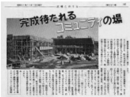
コミュニティセンター建設工事の様子 (昭和51.11.15 第231号)
