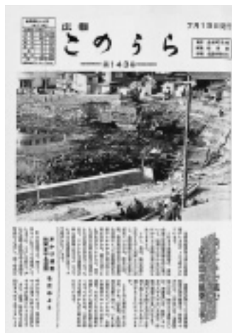
急ピッチで進む金浦漁港修築工事 (昭和44.7.15 第143号)
