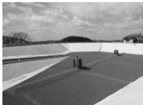
金浦町一般廃棄物最終処分場
