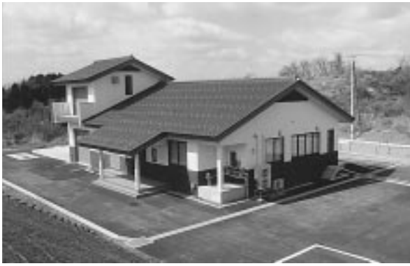
「一般廃棄物最終処分場」
