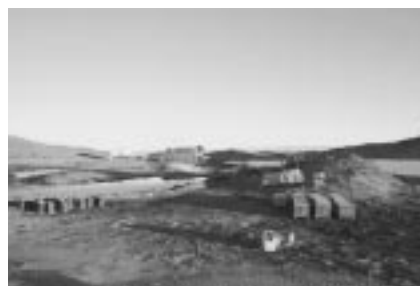
まるで工事現場のようです
