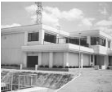
金浦町浄水場 (大竹地内)
