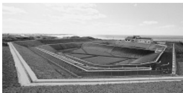
◀今後15年間、仁賀保・西目両町の不燃ごみを埋め立てる一般廃棄物最終処分場
