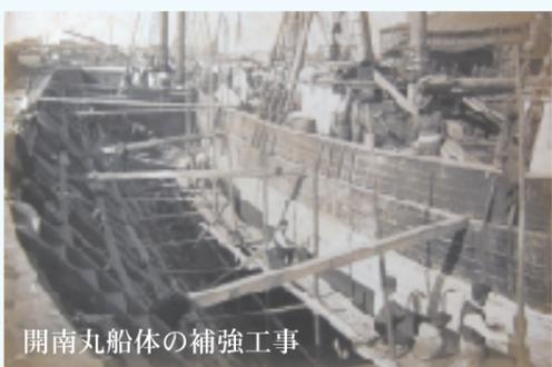
開南丸船体の補強工事
