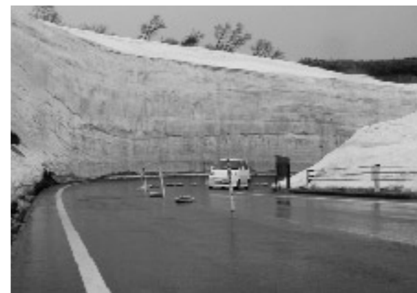
約9メートルの雪の回廊
