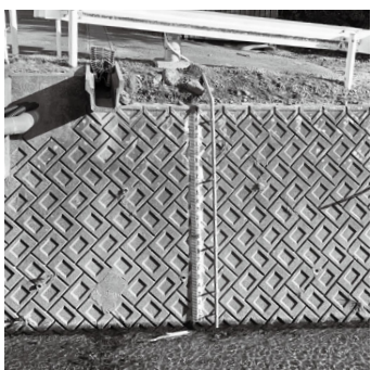
川袋川に設置した水位計
