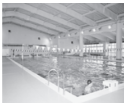
プールなど全面塗装改修
